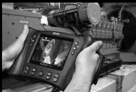
Ispezione di un generatore
